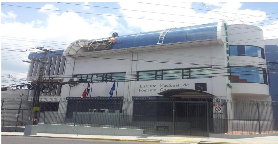
Sustitución del acrílico del auditorio Edificio Principal por deterioro y desprendimiento de la cubierta anterior.
