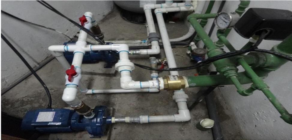
Sustitución del sistema de bombeo de agua potable del Edificio Central
